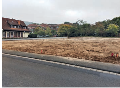
Aktueller Zustand der Baustelle des neuen Kindergarten
